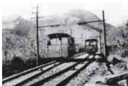
レトロな車両が行きかう開業当時のケーブルカー。料金は25銭。約10分の所要時間は、今も昔も変わらない。
